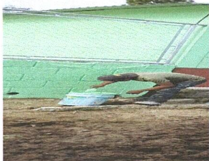
Foto 1: MEJORAMIENTO DE 475M2 DE PINTURA GENERAL EN TODO EL ESTABLECIMIENTO.
