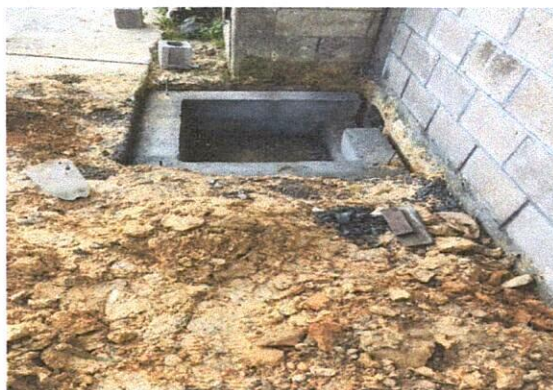
Foto 4: MEJORAMIENTO DE 24ML DE TUBERÍA DE AGUA PLUVIAL MAS UNA CAJA PARA TUBERÍA
