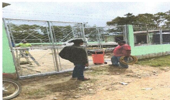
Foto 2: MEJORAMIENTO Y REPACION DE PORTON GENERAL DE INGRESO
